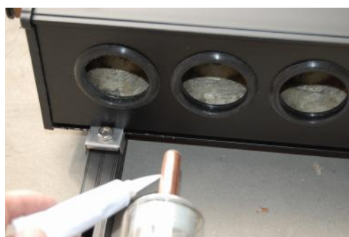
Husk at påføre zinkpasta før monteringen af solfanger røret.
